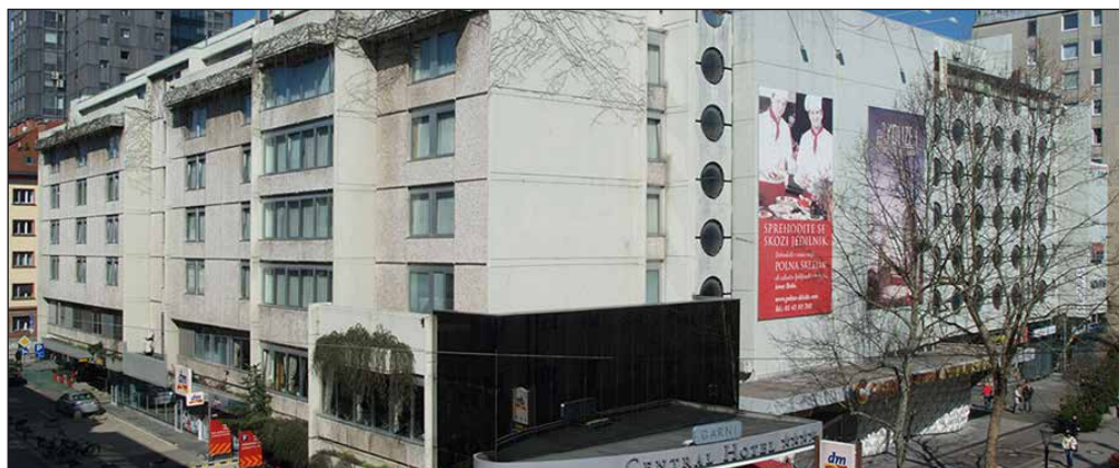
Slika 2. Trdinova garaža u poslovno-hotelskoj zgradi.
